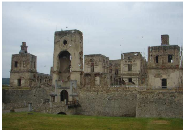
Obr. 4 c). Pohled ze zmoklého autobusu na přístupovou bránu Paláce Krzyżtopór (foto J. Schweigstilllová).
