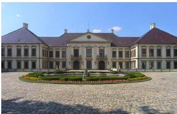
Obr. 6 Pohled na zámek Koloděje
